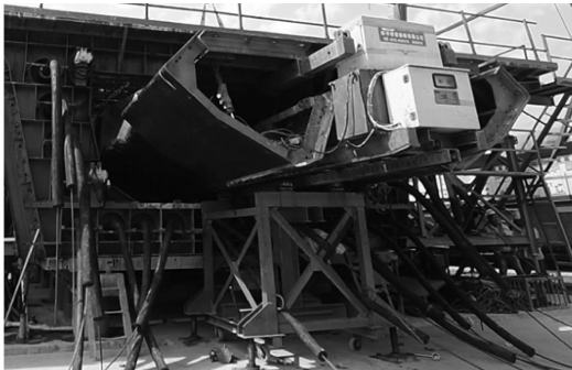
图2 箱梁自驱式内模进出筋笼和梁体施工
