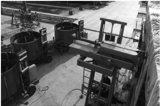
图3 预应力成品束钢绞线穿束台车
