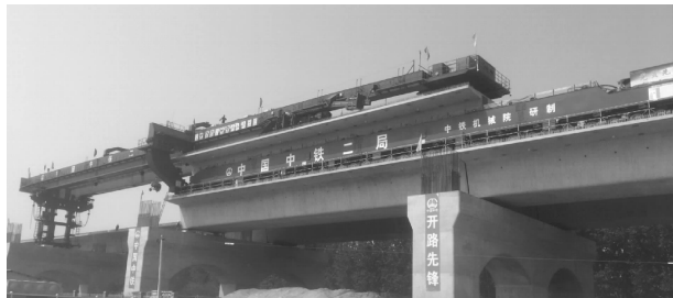
图6 40m/1000t 级箱梁架设
