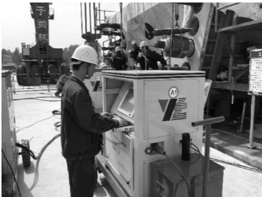
图4 预应力筋自动张拉设备
